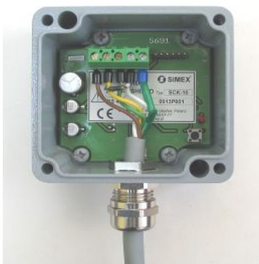
Rys. 4.4. Prawidłowo wykonane połączenie
